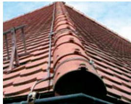
Satteldach mit Leitungshalter
